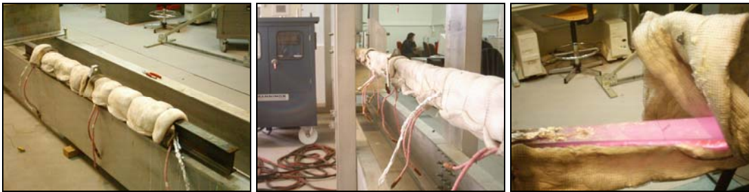
Figura 4.18 – Isolamento térmico das vigas.
